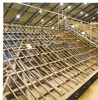
③板葺きをとり除いた 垂木の屋根
