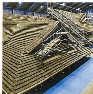
②瓦をとり除いた 板葺き屋根
