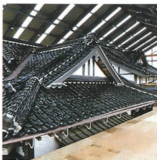
①修理前の駅舎屋根
